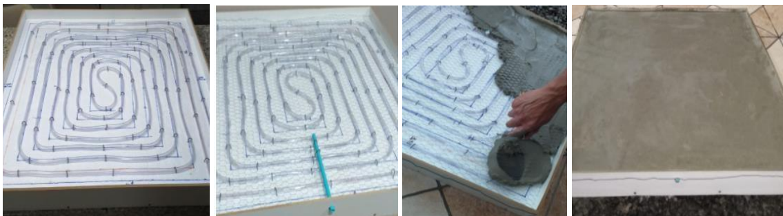
Figura 3. Sequência cronológica (da esquerda para a direita) da montagem do piso radiante hidráulico utilizado para auxiliar na manutenção da temperatura corporal de cadelas durante a recuperação anestésica.
